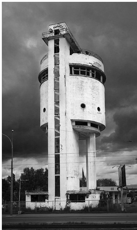
Ил. 3. Сергей Крылов. Водонапорная башня завода УЗТМ г. Свердловск («Белая башня»). Архитектор М. Рейшер
