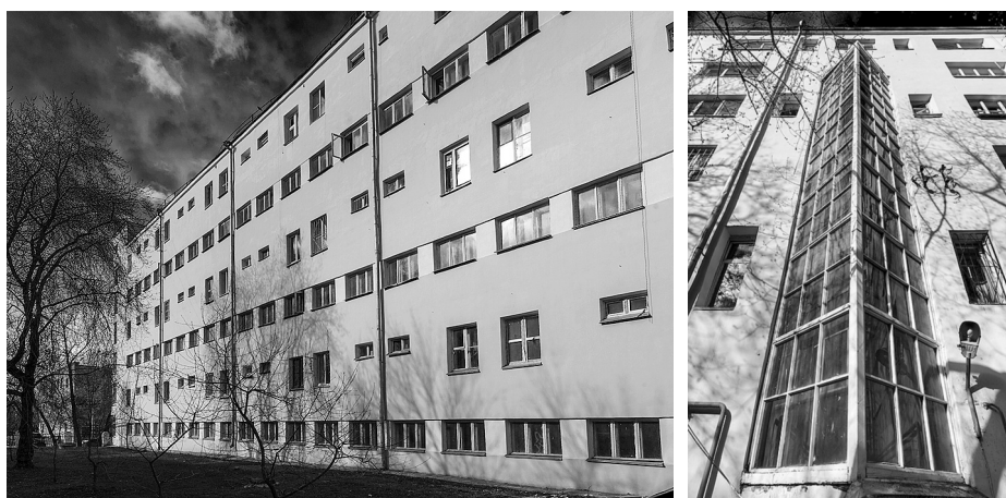
Ил. 2. Сергей Крылов. Дом-коммуна. Комплекс домов «Госпромурала». Архитекторы Г. Валенков, Е. Коротков. Строительство 1930—1936 годов
